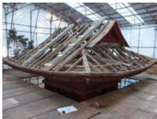
図 5-1 建造物保存修理状況 (瑞雲院鐘楼 天竜区)
