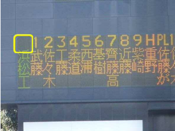
【電光掲示板】 表示不良
