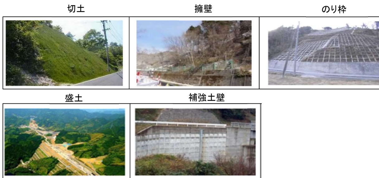
図 2.3 道路土工構造物の例
