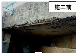
【橋りょう修繕実施状況】
