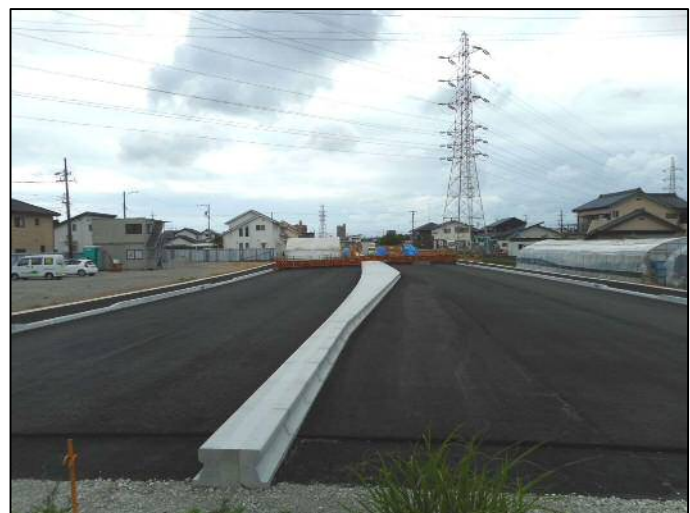
【市道有玉南初生線バイパス整備状況】
