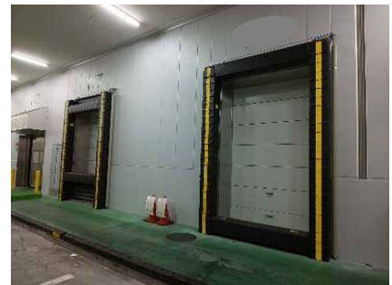
ドックシェルター付きトラックバース
