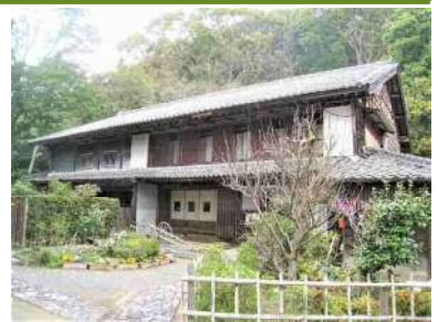
旧田代家住宅主屋 外観
