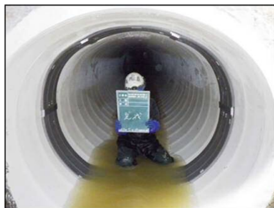
<改築後>管更生を実施した管路
