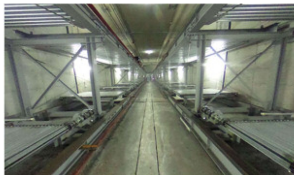
地下 2 階 格納ます全景
