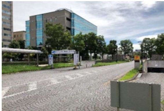
出入口スロープ
