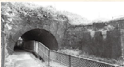
▲まるがた通路(東海道線複線化開通に伴い建設)
