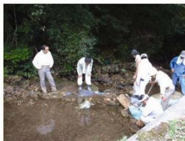
水田への配水のための堰づくり
