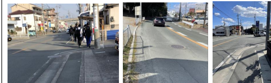
左側: 上島駅へ向かう利用者 右側2枚: 歩道の途切れた道路(上島萩丘線) 撮影: 平間良明
