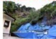
豪雨の度に土砂崩れが多発
