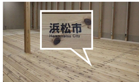
事務所の柱や床に天竜材が使用されている選手村ビレッジプラザ
