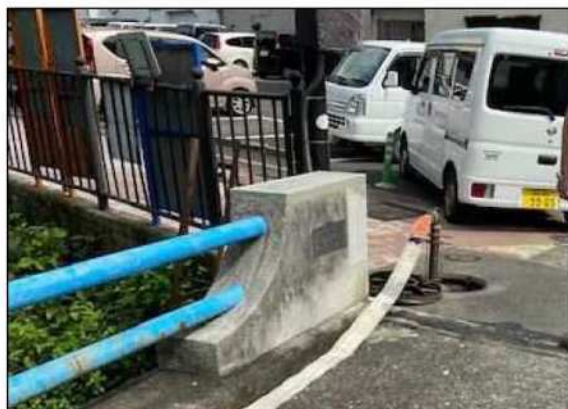
湯河原側側排泥口
