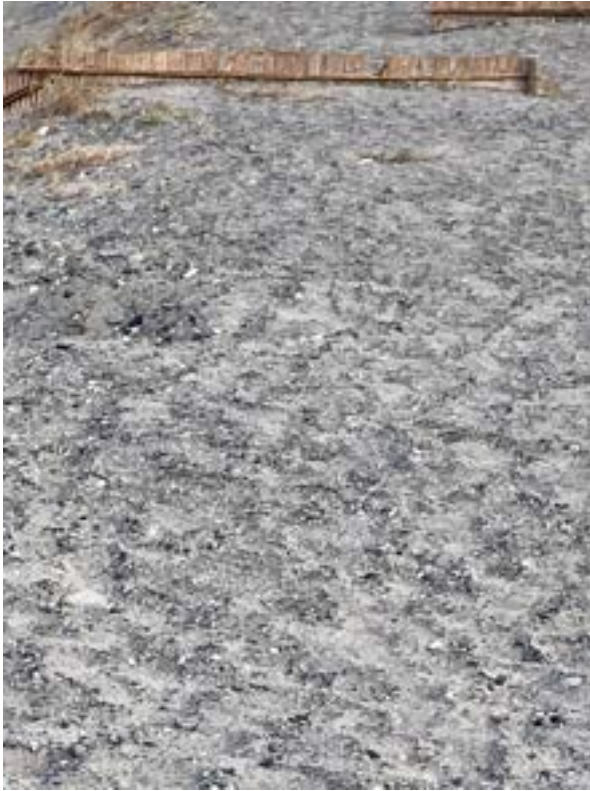
防潮堤の歩道部分。砂利で覆われている
