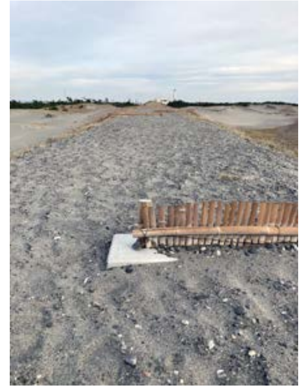
防潮堤の上部にある低い堆砂垣
