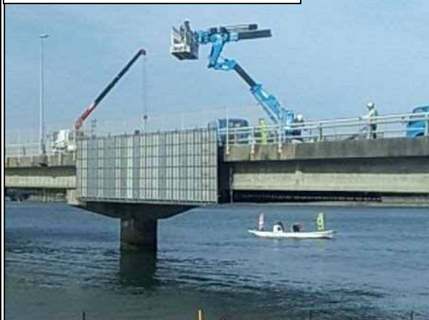
県道館山寺弁天島線(中之島大橋) 橋りょう長寿命化事業
