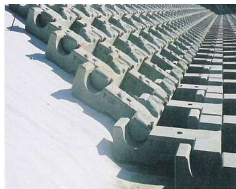
施工イメージ (大型連結ブロックの施工の様子)
