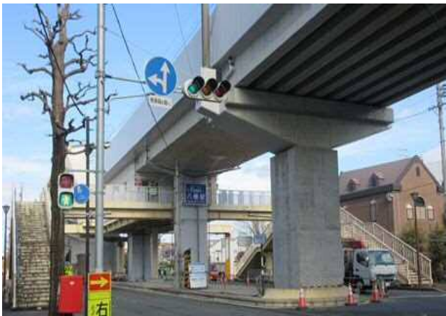
【遠州鉄道八幡駅及び遠州八幡停車場歩道橋】
