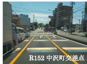
事故多発交差点 (イメージハンプ設置)
