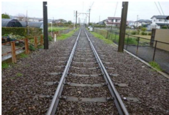
【線路設備（PC マクラギ増設）】
