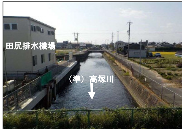
高塚川排水機場新設予定箇所
