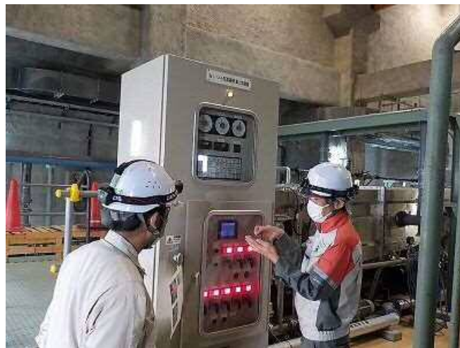
点検支援ツールを使用した日常点検の確認
