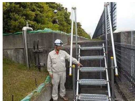
図9 安全対策（転落防止階段設置）
