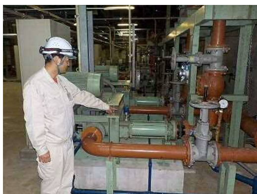
図 13 内製化による汚泥ポンプ部品取替状況
