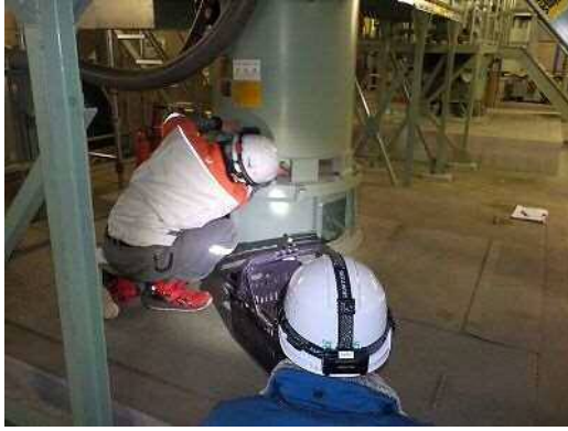
図 14 サーモクロン取付および PC による劣化状況の確認
