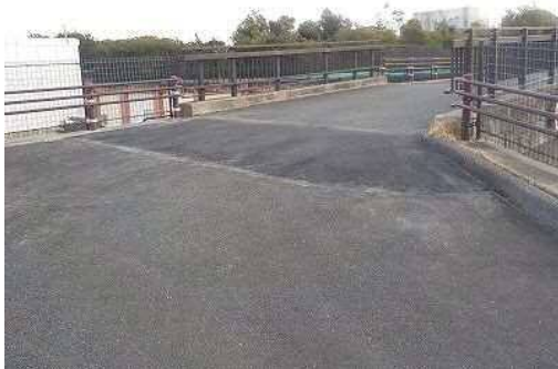
図8 安全対策（公園連絡通路スロープ）
