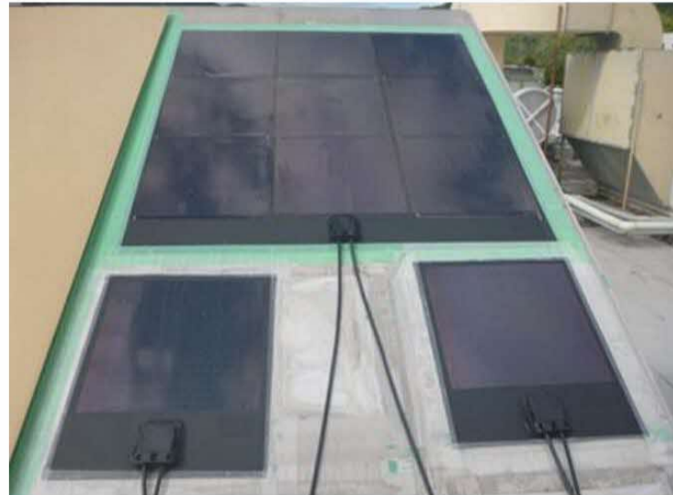
積水化学工業研究所での屋上試験
