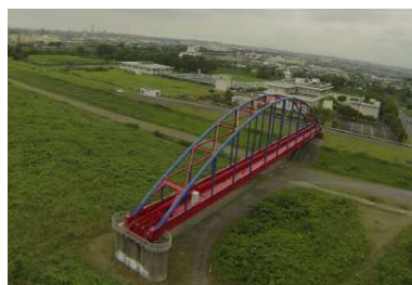
常光浄水場水源天竜川伏流水 取水施設と導水管 (水管橋)
