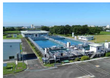
常光浄水場浄水施設
