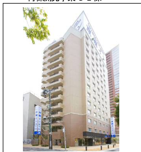
《 旭・板屋地区第一種市街地 》 再棟開発事業 B-2 棟
