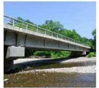
※通常地覆水切りが上床版まで打ち下ろされているため、床版位置が確認できない。
