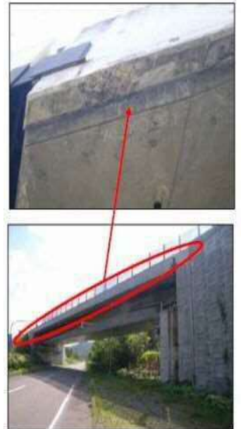
※通常地覆水切りが上床版まで打ち下ろされているため、床版位置が確認できない。
