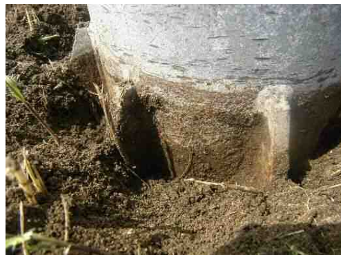
写真 4-2 支柱基部（路面境界部）の点検
