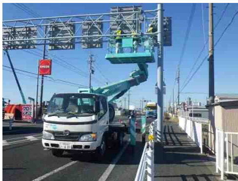
写真 4-1 高所作業車による近接目視点検
