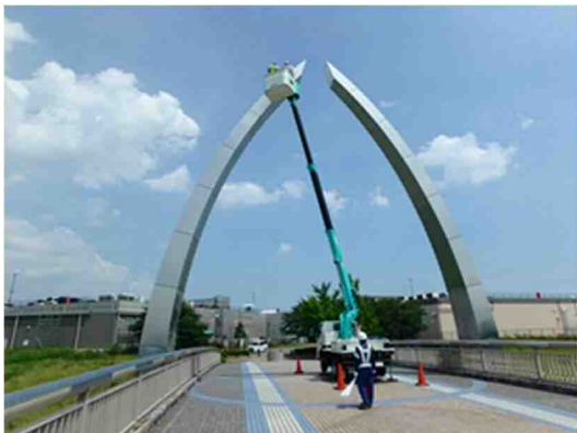
写真 4-1 高所作業車による近接目視点検
