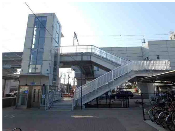
【鋼橋】市道曳馬中田島線_助信駅自由通路
