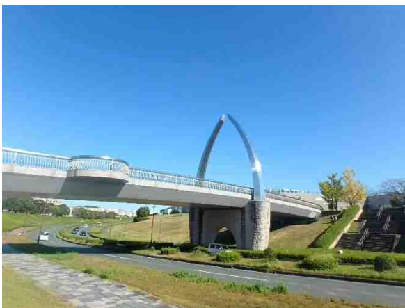
【コンクリート橋】市道東三方都田線_北都橋歩道橋
