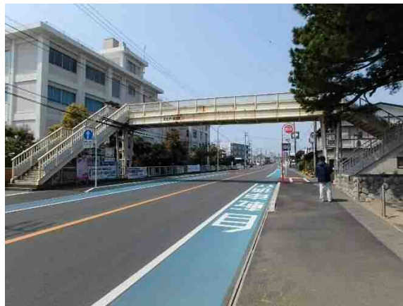
【鋼橋】国道 257 号_増楽歩道橋
