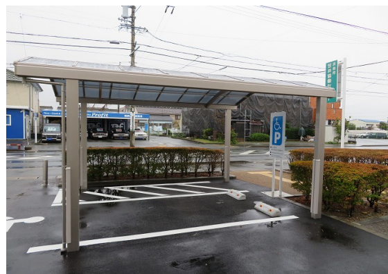
身障者駐車場（新設）
