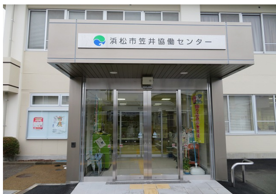
協働センター入口（南側へ移設）
