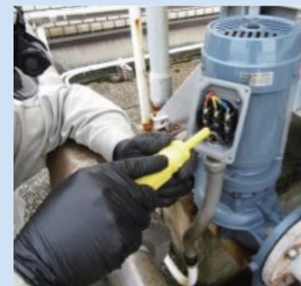
【ポンプ保全に関する技術研修】
