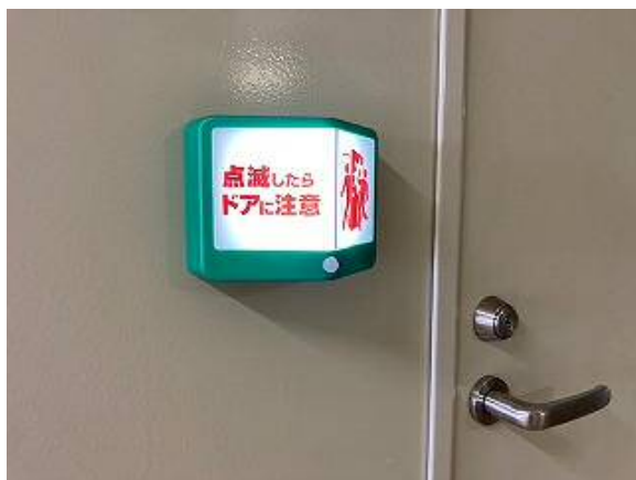
図7 安全対策（衝突防止センサーライト）
