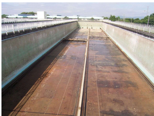
[参考] 耐震補強前の沈澱池
