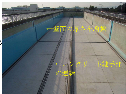
[参考] 耐震補強後の沈澱池
