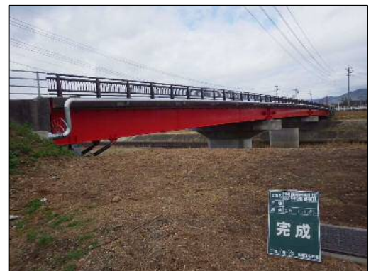
新祝田橋の橋梁補修工事
