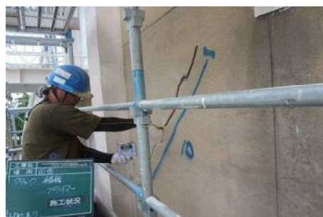
小規模改修工事(外壁改修)
