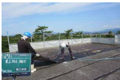
小規模改修工事(屋根改修)
