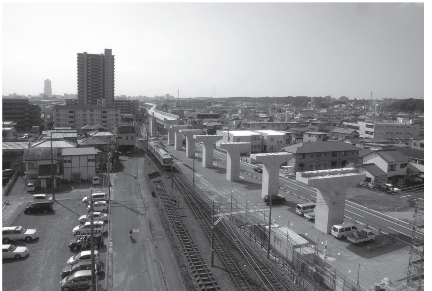
高架化の工事が進展する遠鉄上島駅の周辺。3年後、この光景はさらに大きく変化しているでしょう
