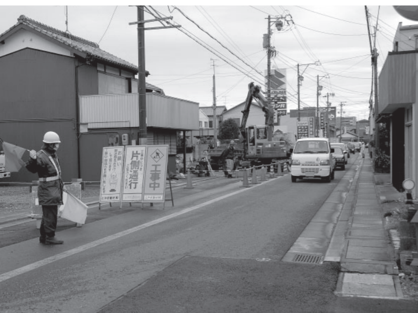
道路工事のため片側通行となっている、ドライバーには見慣れた風景
