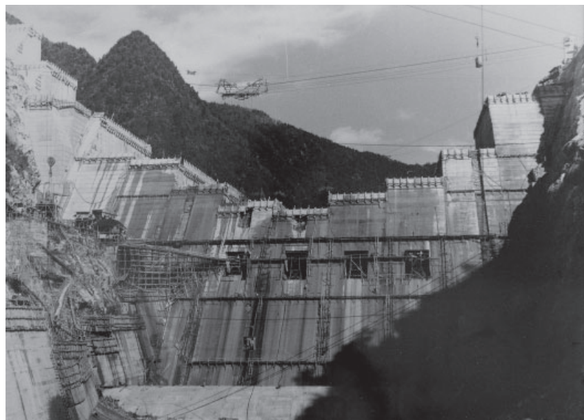
昭和28年から3 年間で建設された 佐久間ダムの工 事現場
