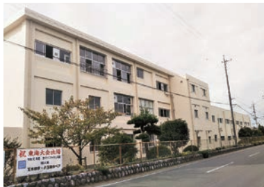
長寿命化工事を実施した校舎(北浜中学校)
