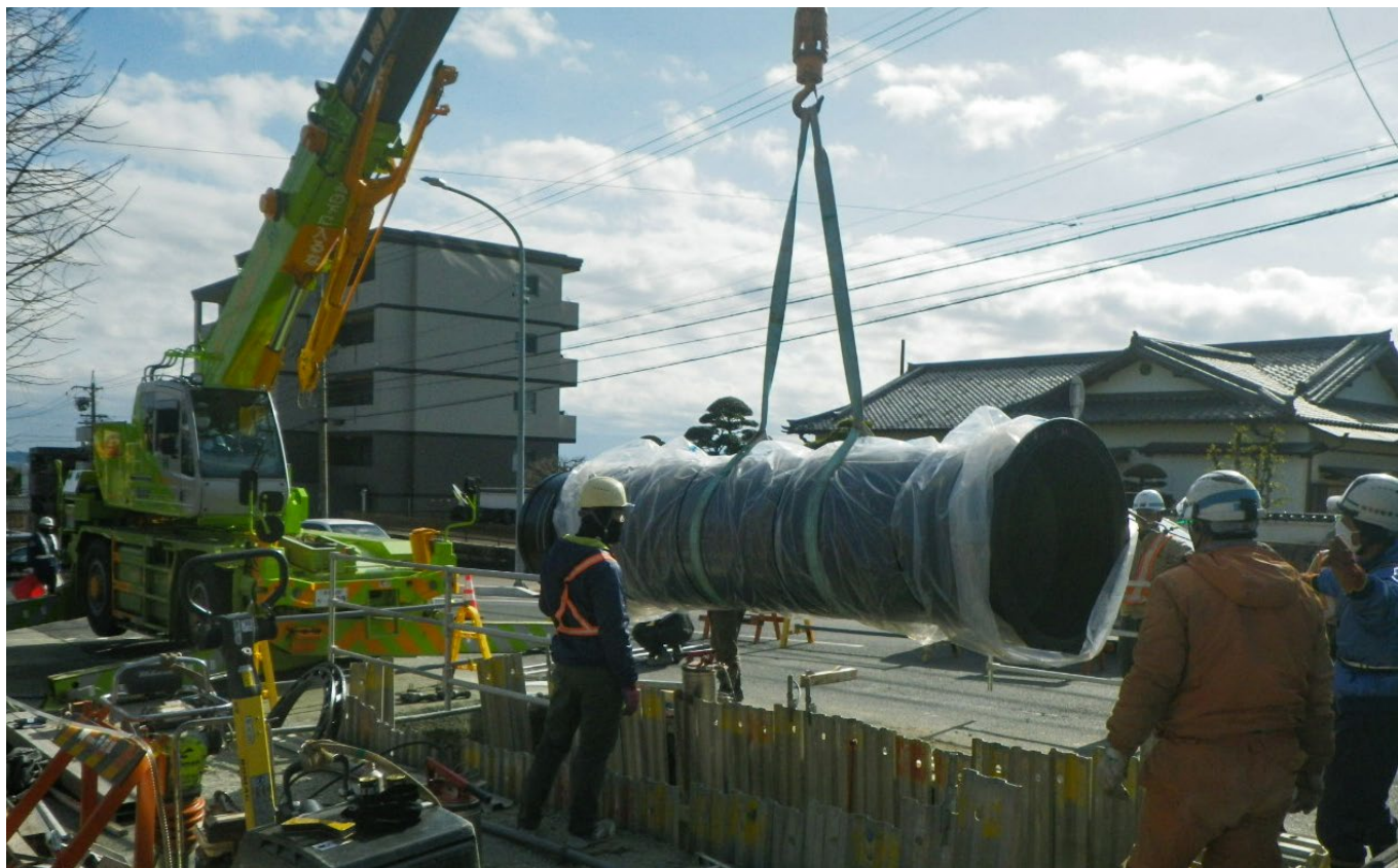
▲ 上水道基幹管路耐震化
