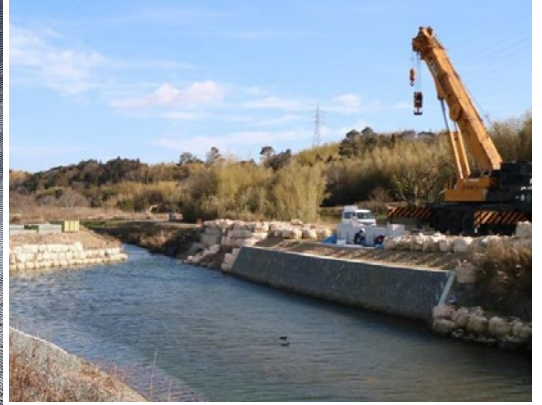
▲ 浸水対策のための河川工事
