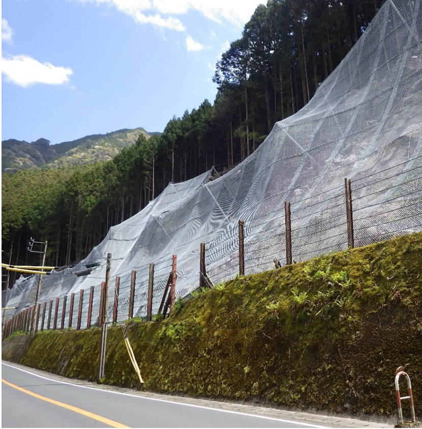
▲ 道路防災対策
