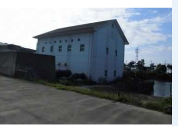
寺脇排水機場
