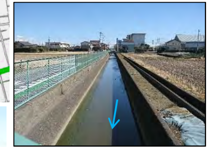
飯田排水路の様子
