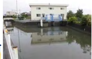
中田島排水機場
