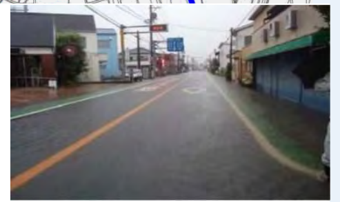
国道150号芳川交番付近の道路冠水 (平成27年9月)
