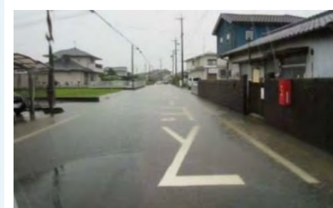
道路冠水(中央区天王町) (平成27年9月降雨)
