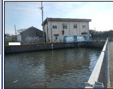
田尻排水機場
