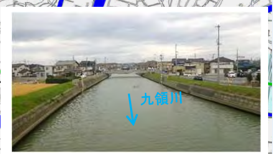
九領川河川改修区間 (志都呂町)
