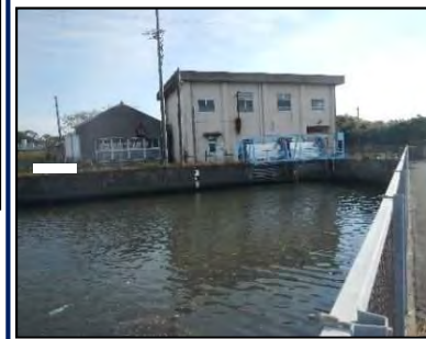
田尻排水機場
