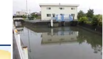
中田島排水機場
