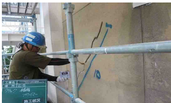
小規模改修工事（外壁改修）
