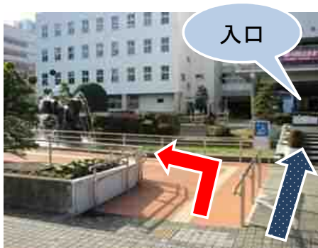
●バリアフリー化された玄関前
