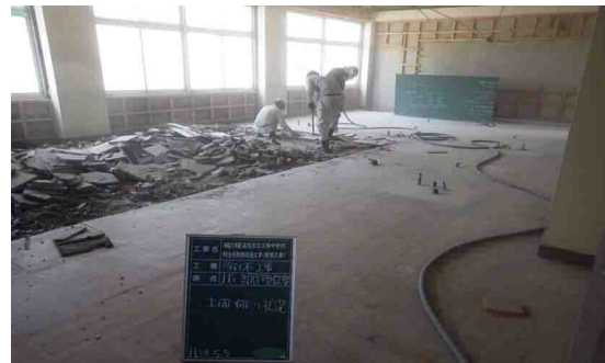
大規模改修工事
