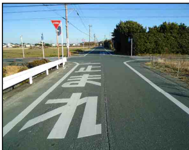
▲道路法定外表示(止まれ)の設置
