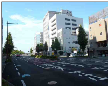
▲交差点改良、追突注意等の路面表示による注意喚起
