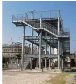
【津波避難タワー】
