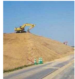
【沿岸域防潮堤：建設中】
