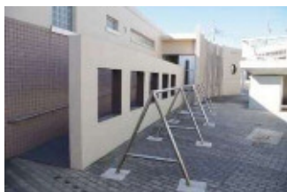
図 サイクルラック設置状況
