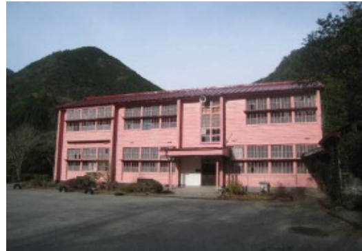
旧気多村立勝坂小学校校舎（天竜区春野町豊岡：国登録有形文化財 建造物）
