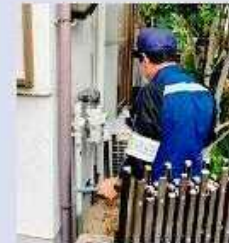
開栓作業の様子(大阪府北部地震中部ガス応援隊)
