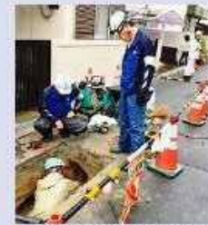
ガス管修繕の様子(大阪府北部地震中部ガス応援隊)
