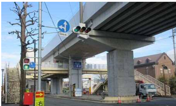
【遠州鉄道八幡駅及び遠州八幡停車場歩道橋】
