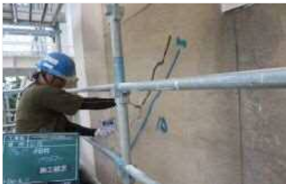
【小規模改修工事(外壁改修)】
