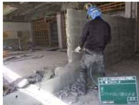
【大規模改修工事】
