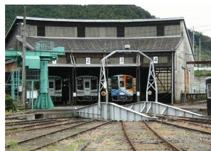
図1-6-16 天竜浜名湖鉄道機関車転車台・機関車扇形車庫
