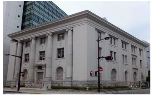
図2-1-12 静岡銀行浜松営業部本館
