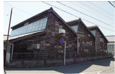
図2-2-26 三連のこぎり屋根の織物工場
