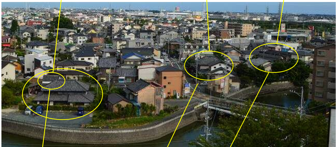
図2-2-27 土橋(佐鳴橋)付近のまち並み 令和2年(2020)撮影
