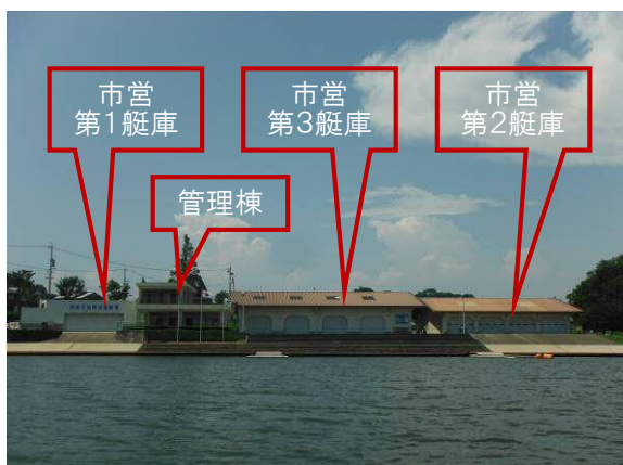
図2-2-14 佐鳴湖漕艇場の管理棟と第1、第2、第3艇庫
