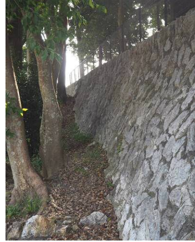
図2-2-34 八幡神社の護岸遺構
