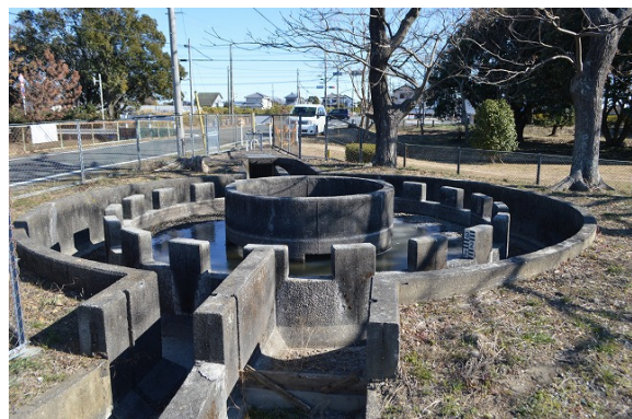
図2-4-10 三方原用水13号分水工(円筒分水)
