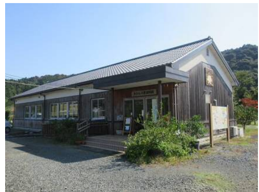
図2-8-32 旧三ヶ日小学校大福寺分教場(みかんの里資料館)
